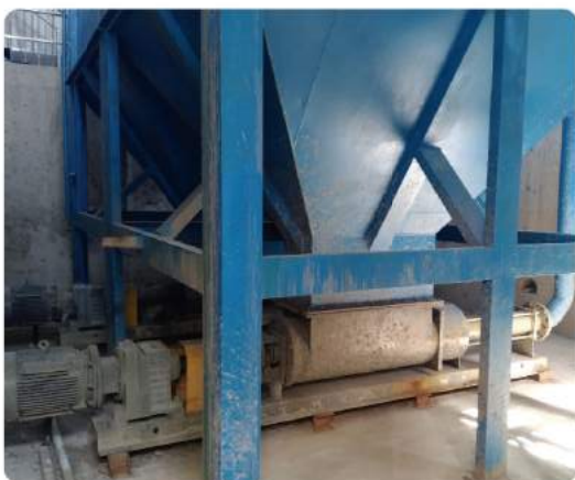
污水处理厂脱水污泥装车
