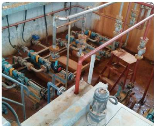
污水处理厂硫酸亚铁计量
