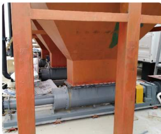
河道处理脱水污泥装车
