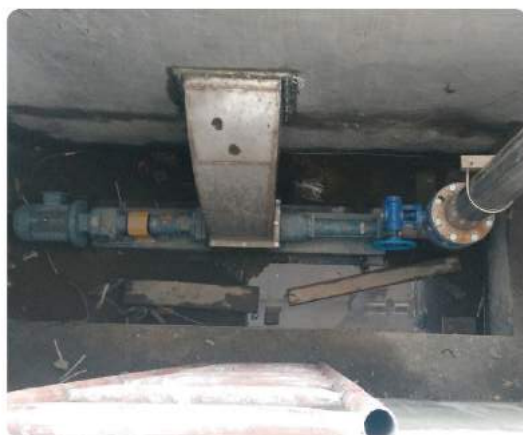
离心机脱水污泥输送
